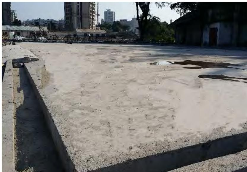
图 7-1 建筑垃圾堆置场地混凝土地坪示意图
