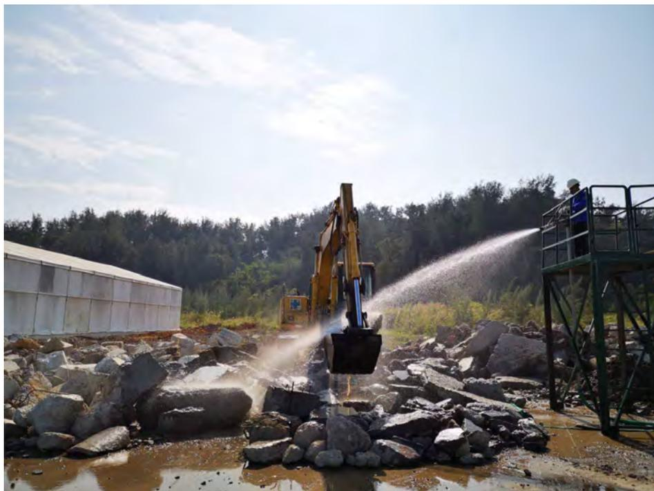
图 6-23 污染建筑垃圾冲洗示意图
