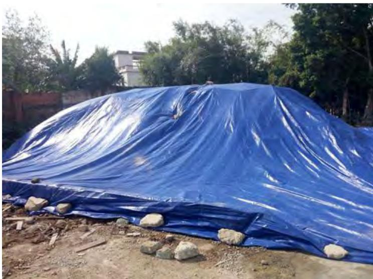
图 6-25 冲洗后建筑垃圾的堆置示意图
