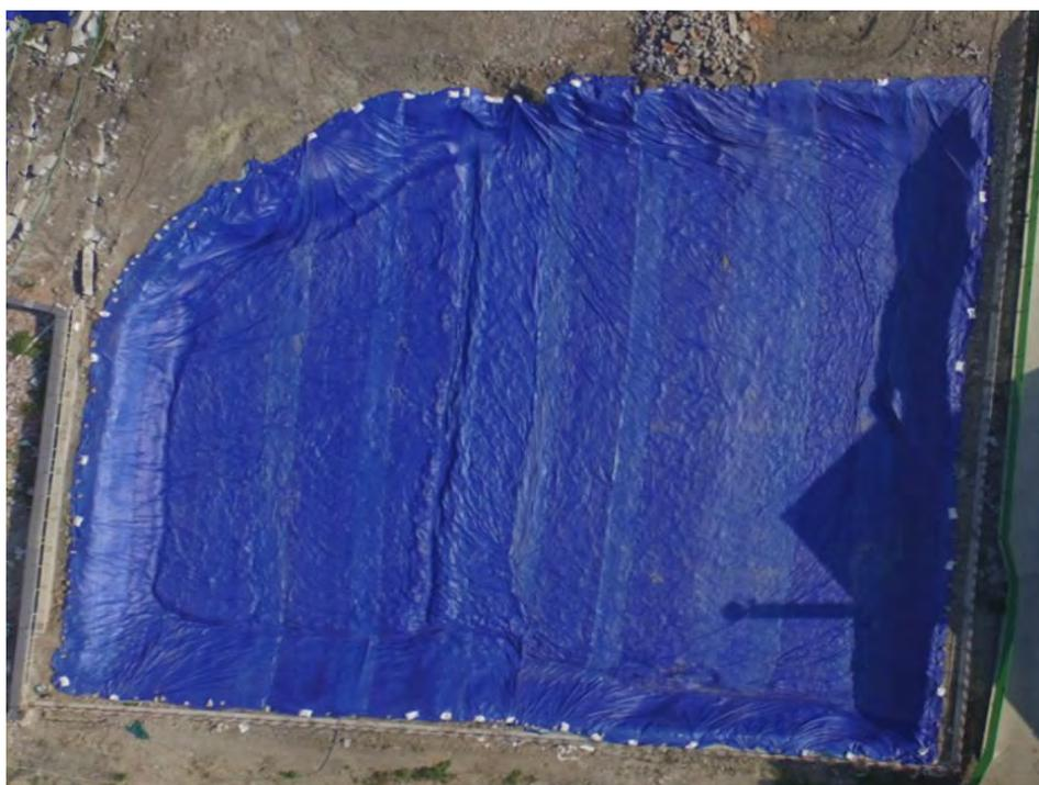
图 10-4 基坑防水膜遮盖示意图
