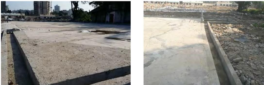
图 7-11 筛上物冲洗区排水沟和沉砂池示意图
