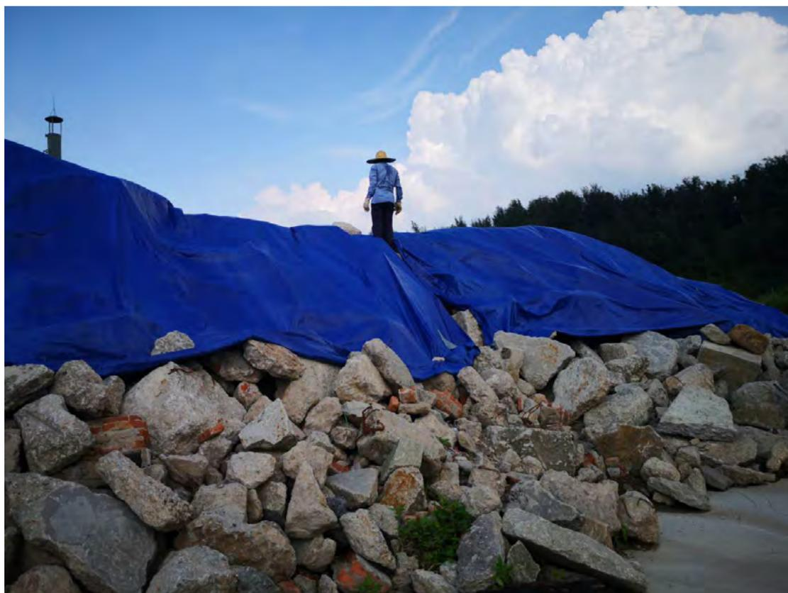
图 7-7 建筑垃圾覆盖示意图
